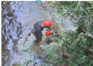
L'abattage est sélectif : arbres morts, penchés ou en mauvais état risquant de tomber dans le lit. Afin de rajeunir la végétation, des opérations de recépage (*coupe pour alléger les arbres et favoriser les buissons qui ralentissent les écoulements*) sont réalisées.
