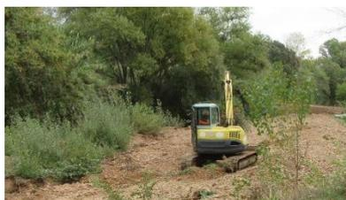
Le traitement se fait par griffage des zones de dépôts de sédiments. L'objectif est d'éviter la réduction de la section d'écoulement par l'enracinement de la végétation sur les atterrissements. Cela permet aux sédiments d'être transportés de nouveau par l'eau.
